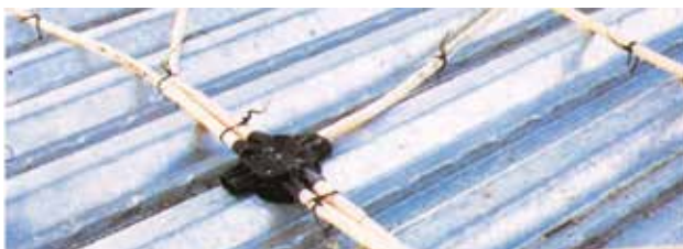
El- och vissa vvsinstallationer kan gjutas in på traditionellt vis.
